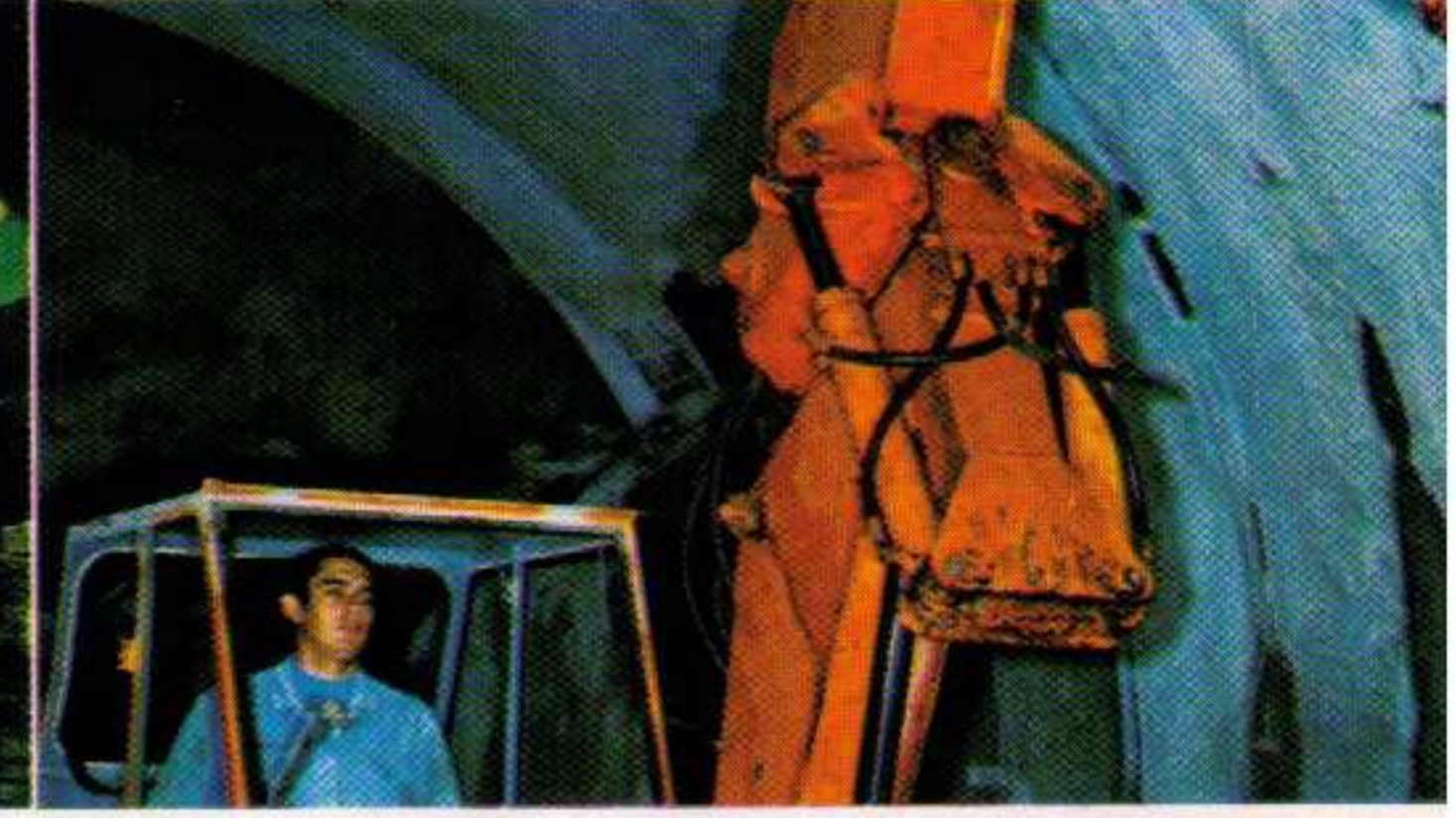
ATLAS-Entwicklung: Armkippgelenk für Arbeiten in der Schräge oder an Böschungen
