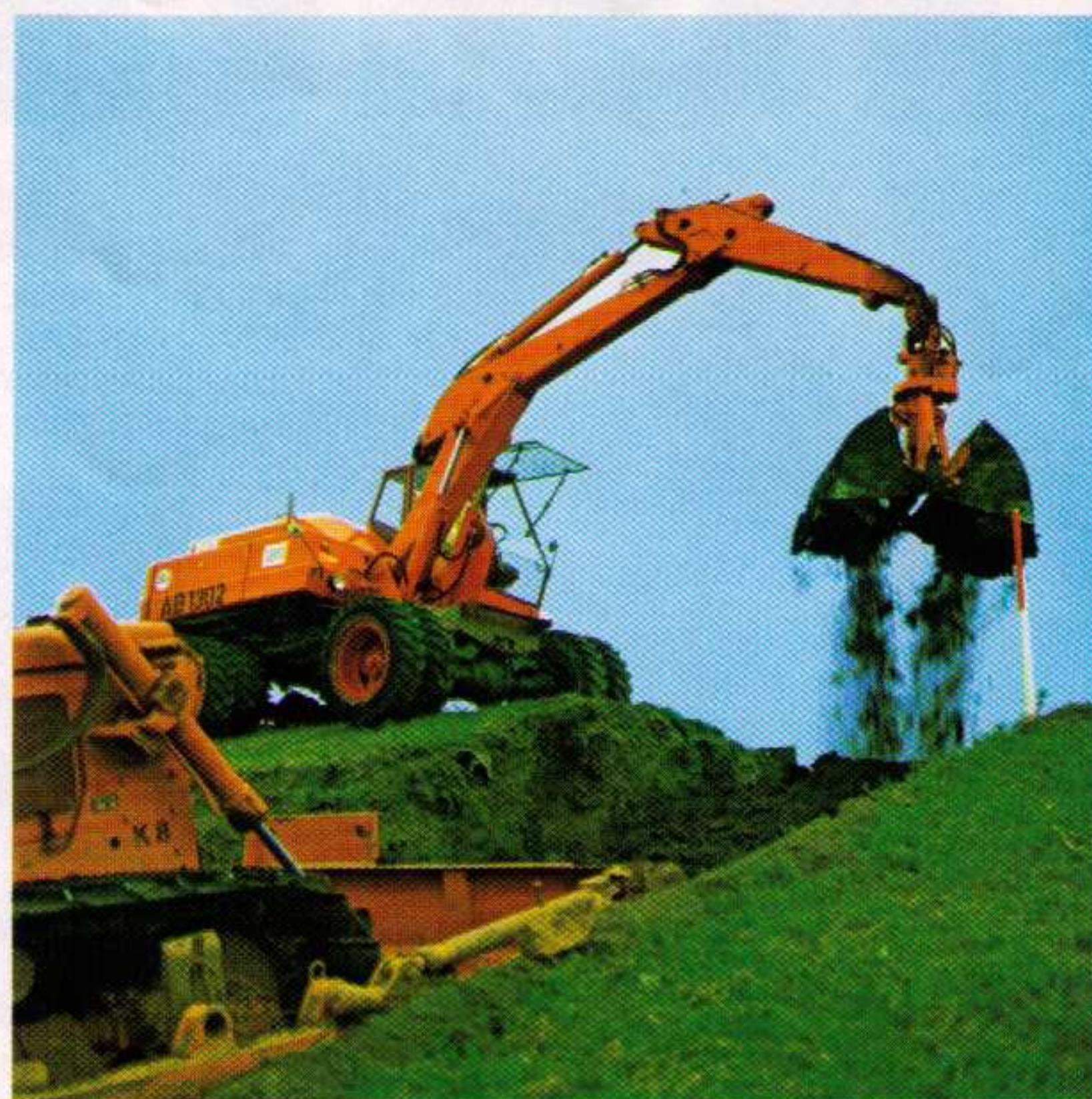
ATLAS-Mobilbagger 1302 beim Deichbau
