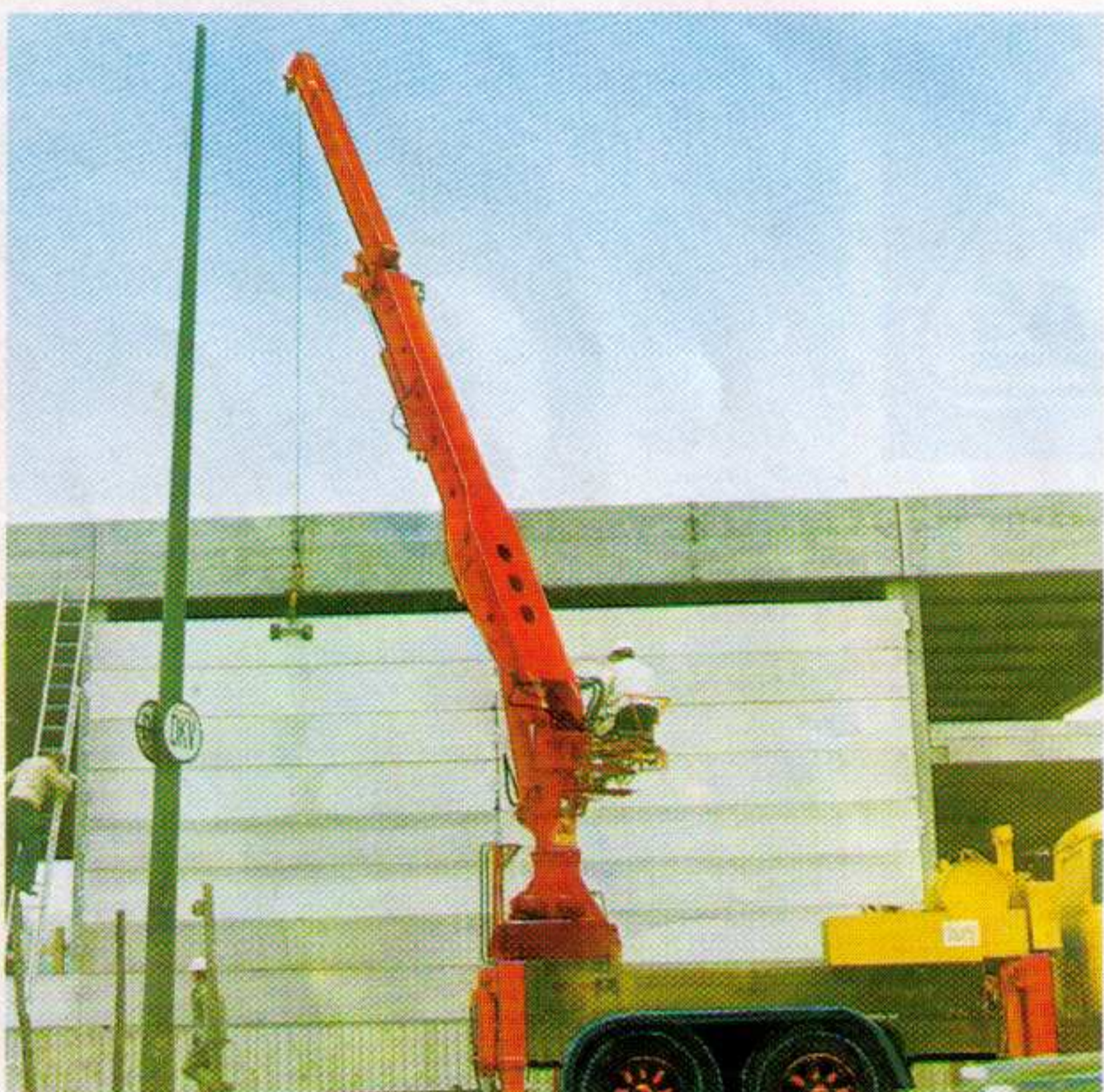
ATLAS-Ladekran 6000 beim Fertigbetonbau
